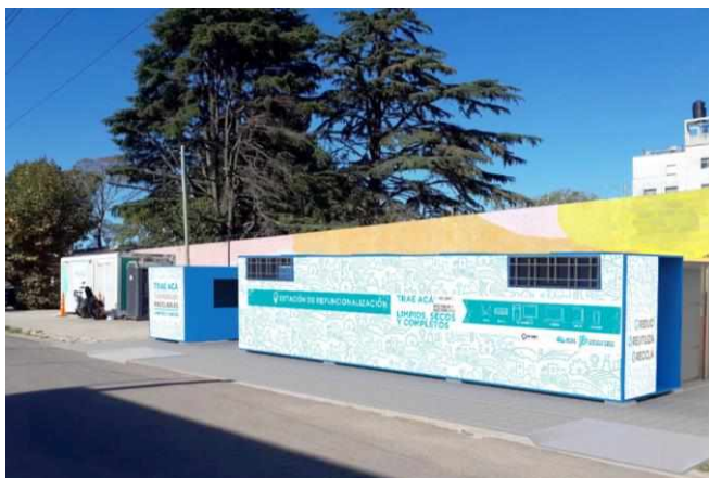
Ilustración 1 Vista exterior del espacio contenerizado
